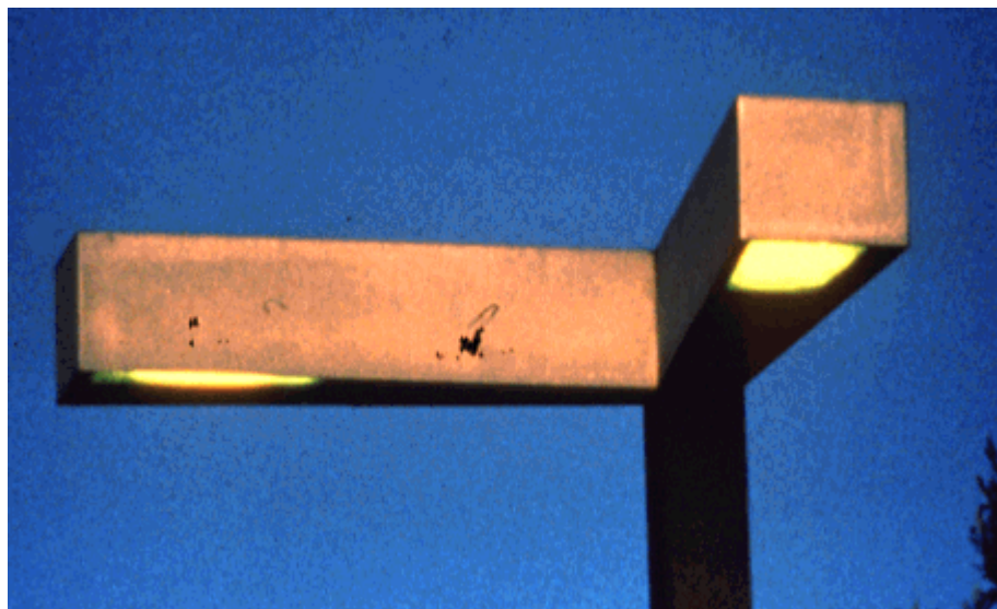
Este es un ejemplo de buen diseño del lámpara que aprovecha casi el 100% de la luz. Como se ve aquí es moderno y su estética no tiene nada que envidiar a muchas de las farolas tipo globo.
