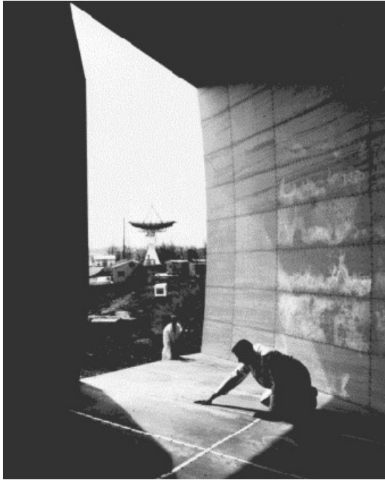
Fig.3: Limpiando la ANTENA DE EXCREMENTOS (Obtenida de LA PÁGINA DE INTERNET www.bell-labs.com/project/feature/archives/cosmology )
