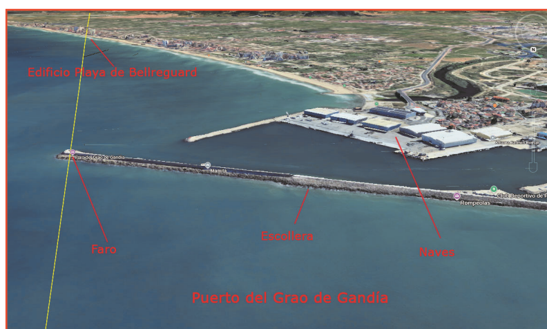
Figura 5: Vistas del puerto de Gandía con Google Earth. Se puede apreciar la línea visual, la playa de Bellreguard y las estructuras del puerto de Gandía.
