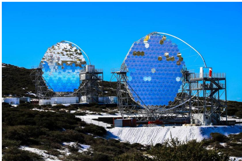
Telescopios Cherenkov en construcción en el Roque de los Muchachos. EFE/Luis G. Morera
